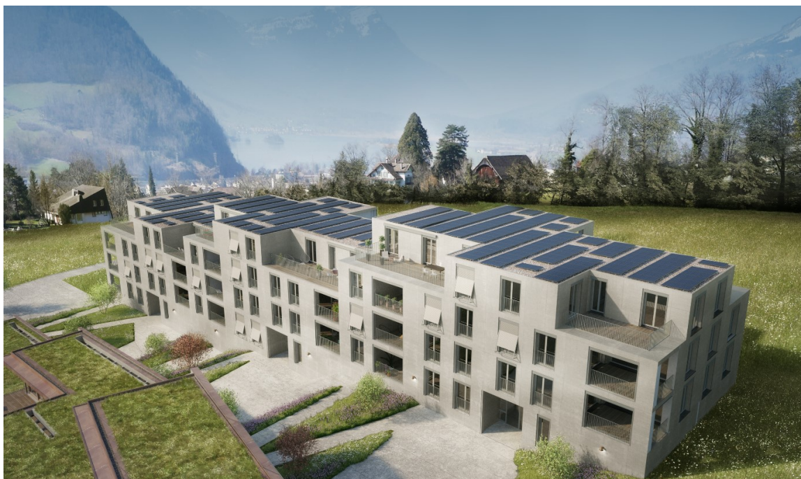
Abbildung 16 Siedlung Mättivor, Schwyz: Strom und Mobilität als ganzheitlicher Ansatz mit Batteriespeicher und E-Fahrzeugladestationen verbunden mit Gebäudeautomation, abgerechnet über ein integriertes Cloud System für das Contracting geliefert von der ecocoach AG. Bildquelle: Cimag AG/ nightnurse images
